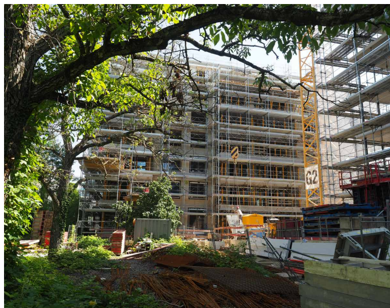
Début de la construction au Chemin du Croissant 2-4 à Vernier (GE)
