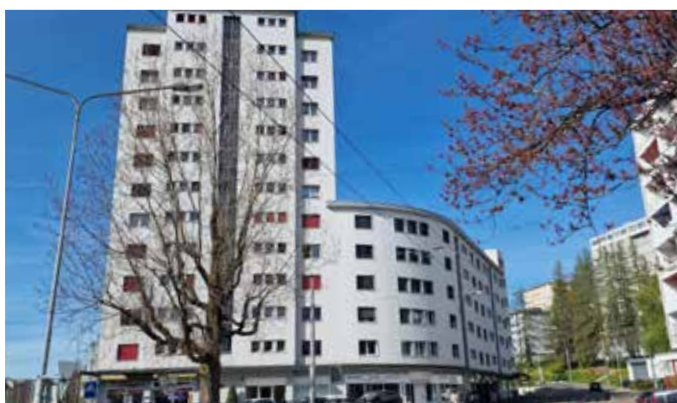
La Chaux-de-Fonds, Avenue Charles-Naine 1-7
